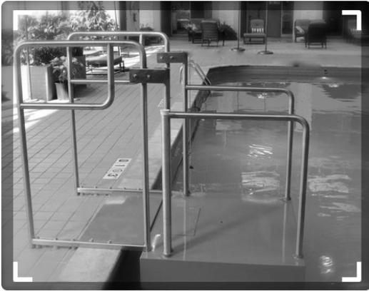
L'accès à la piscine du centre thermal a été aménagé pour permettre aux personnes à mobilité réduite d'accéder au bassin. Un moteur alimenté par une batterie permet de déplacer verticalement une plateforme élévatrice.
